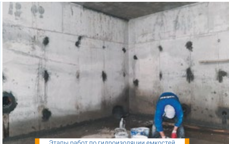
Этапы работ по гидроизоляции емкостей и сооружений механической очистки стоков
