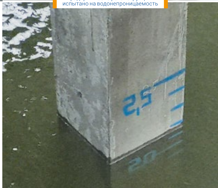
Градирня после реконструкции: испытано на водонепроницаемость
