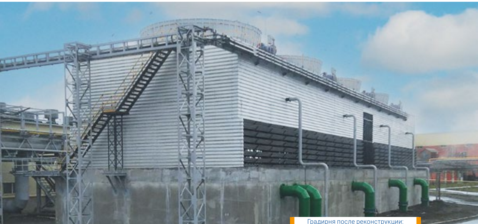
Градирня после реконструкции: испытано на водонепроницаемость
