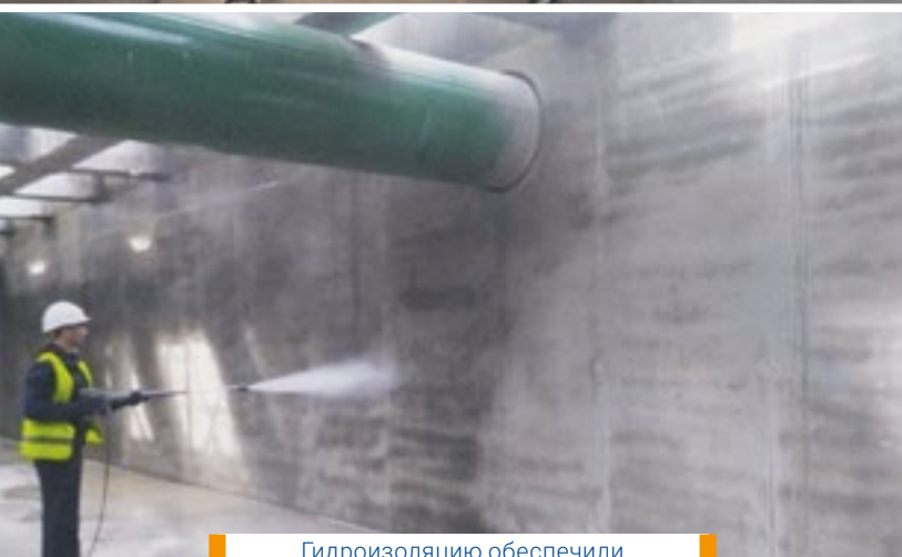
Гидроизоляцию обеспечили материалы «Пенетрон», «Пенекрит»...
