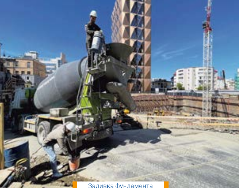
Заливка фундамента с «Пенетрон Адмиксом»
