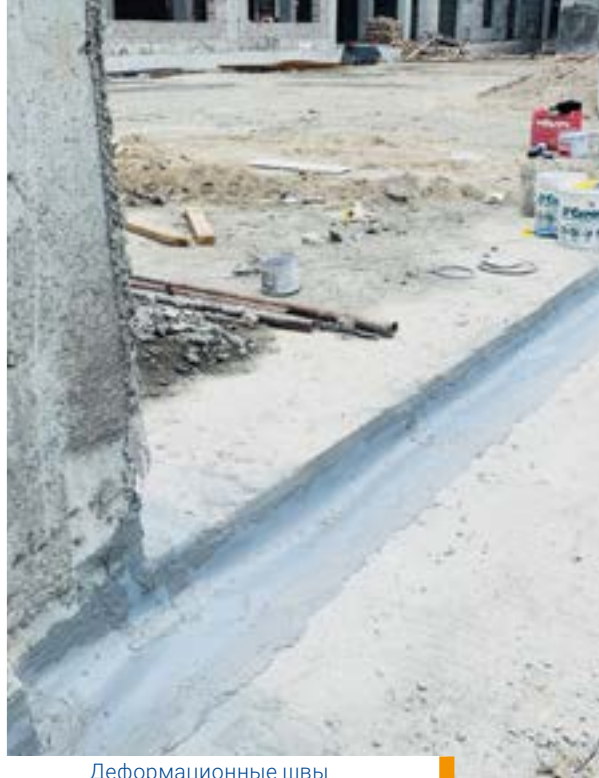
Деформационные швы герметизированы системой Пенебанд С
