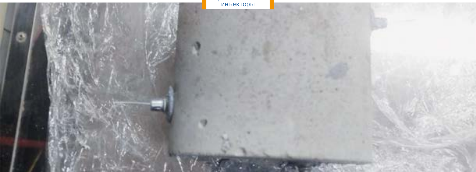
Приклеиваемые инъекторы
