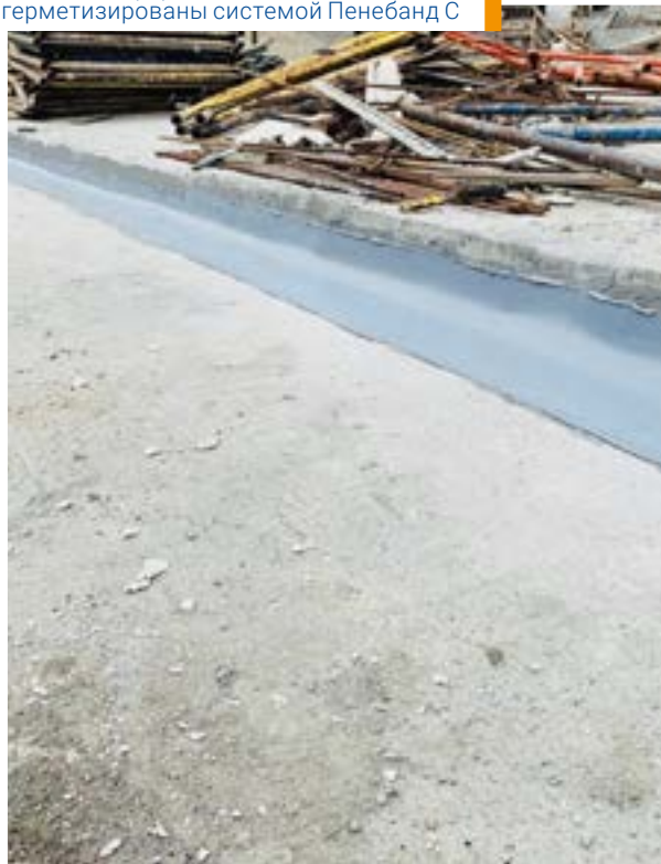
Деформационные швы герметизированы системой Пенебанд С
